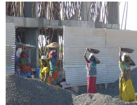
Beton storten bij een nieuwbouw project: 'Als we machines inzetten, hebben de mensen geen werk.'
